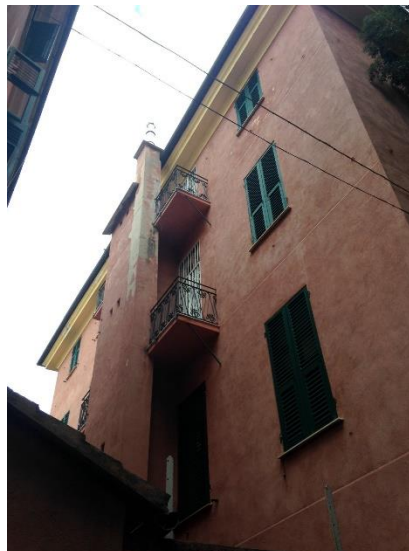
Figura 1.1 - Vista della facciata esposta a Sud
