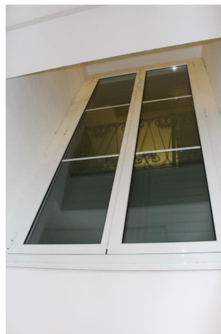
Figura 4.2 - Particolare dei serramenti
