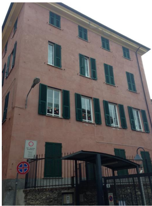
Figura 8.1 - Particolare della facciata esterna
