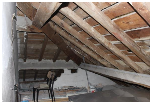
Figura 4.1 - Particolare della porzione di involucro
